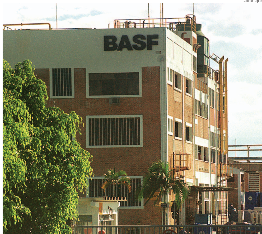
PRODUÇÃO INTERDITADA Fachada da Basf de Guará teve 800 mil litros de agrotóxicos interditados pela Anvisa após técnicos do órgão terem constatado irregularidades no sistema de fabricação dos produtos
